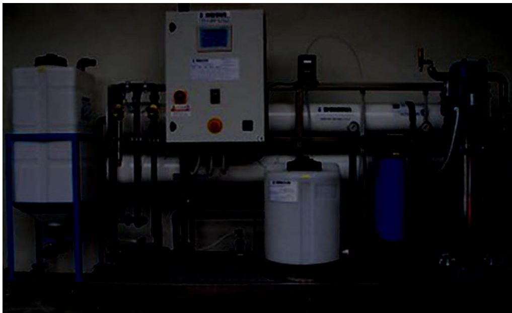
Slika 1. Uređaj za reverznu osmozu u Zvečevu (Izvor:autor)
