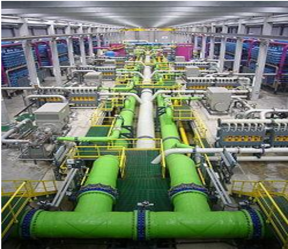
Slika 2. Uređaj za reverznu osmozu u vodoopskrbnom sustavu (Wikipedija,url)
