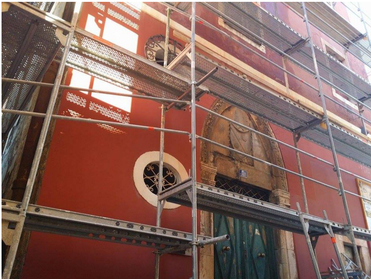
Slika 1. Uporaba tuđe nekretnine radi izvođenja radova
