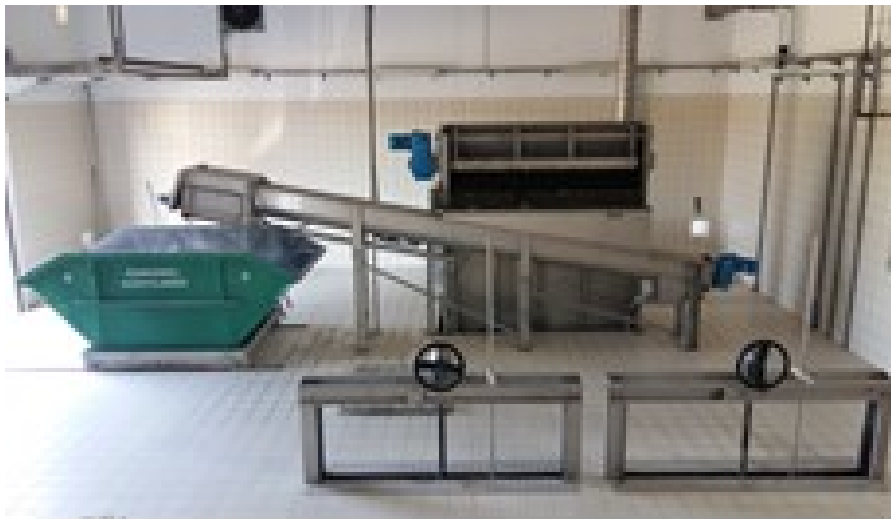
Slika 2. Gruba rešetka (Vodovod Slavonski Brod, n. d., URL)
