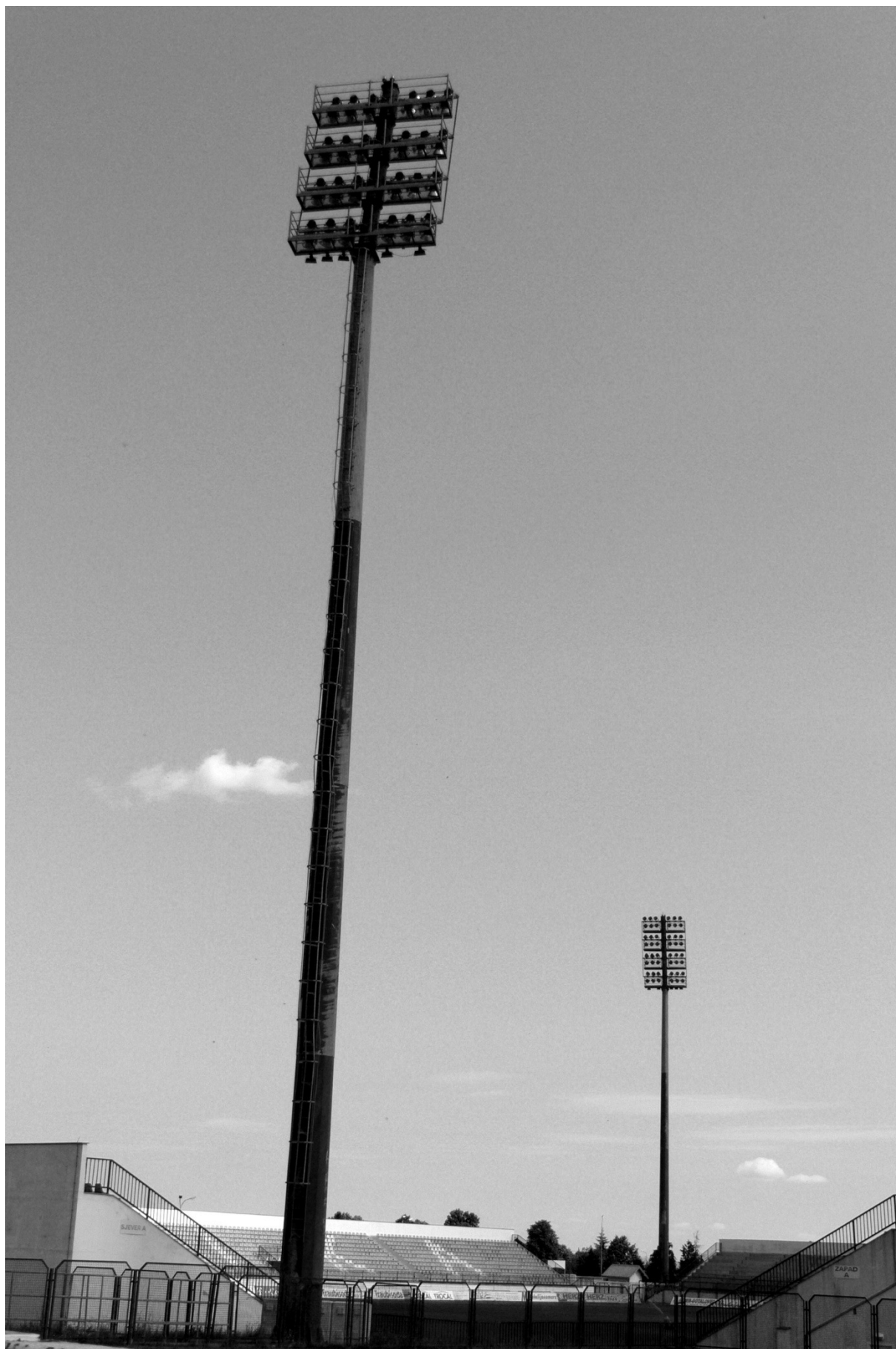
Photo 174. Stadium in Velika / Stadion u Velikoj
