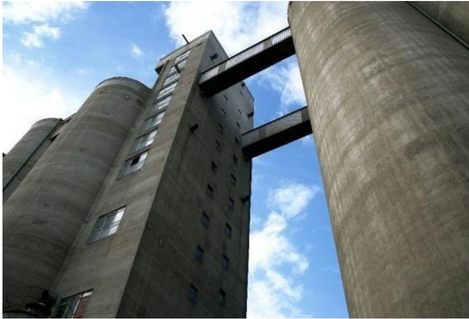
Slika 3. Silosi koji se koriste za skladištenje brašna (Anonymus_6, 24.10.2015., url)
