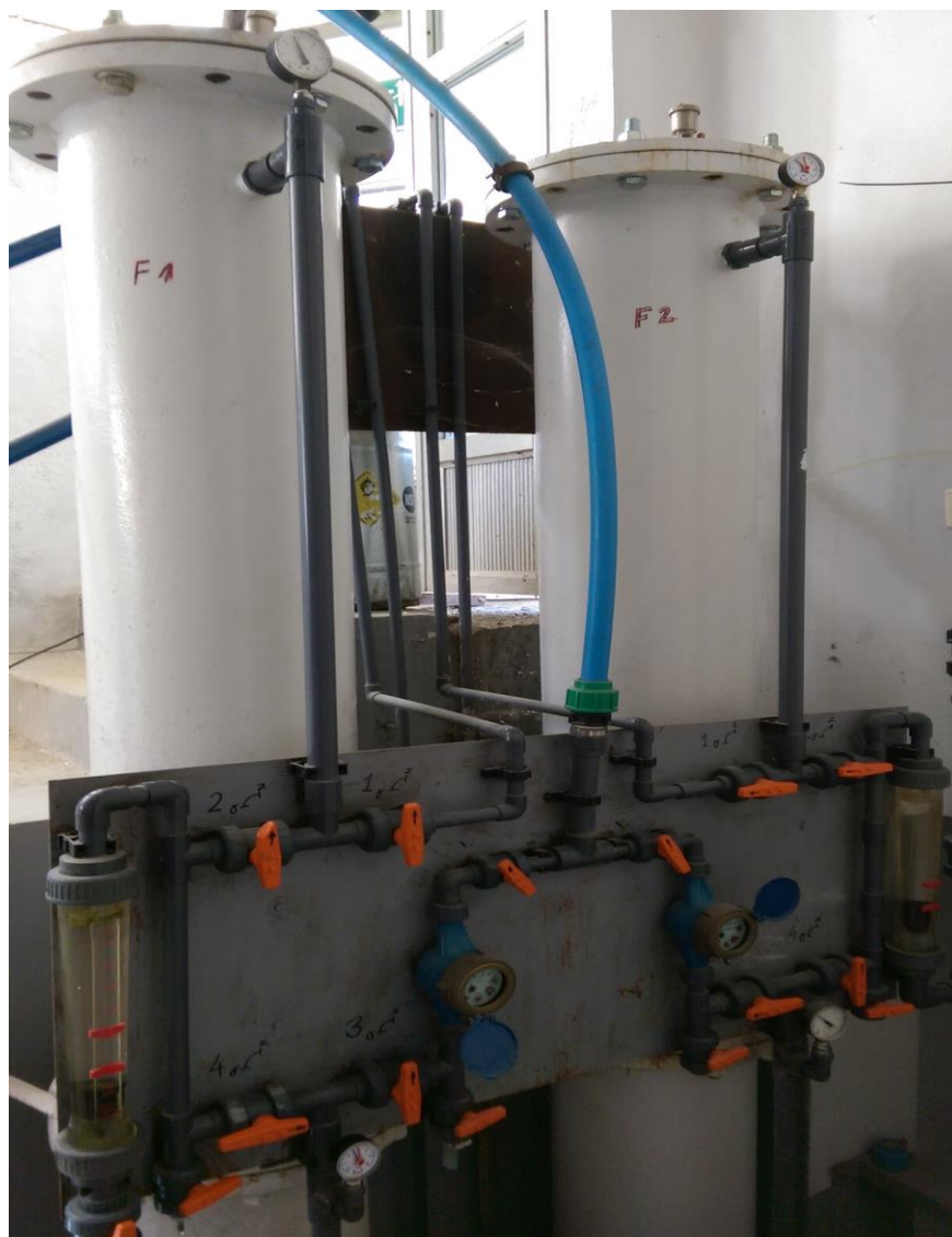
Slika 7. Filtri F1 i F2 u pogonu za preradu vode za ljudsku potrošnju (Izvor: autor)
