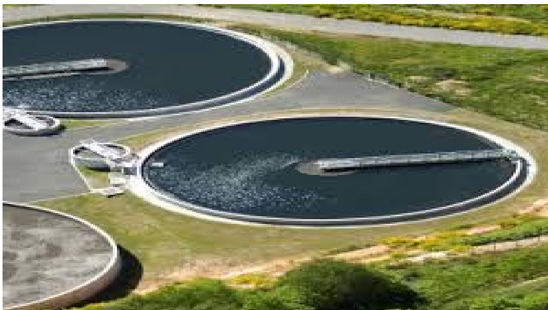
Slika 4. Prikaz uređaja za pročišćavanje otpadnih voda (Anonymus_9, 11.06.2016., url)
