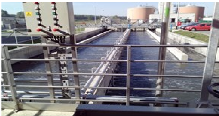
Slika 4. Pjeskolov–mastolov (Vodovod Slavonski Brod, n. d., URL)
