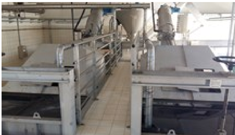
Slika 3. Fina rešetka (Vodovod Slavonski Brod, n. d., URL)
