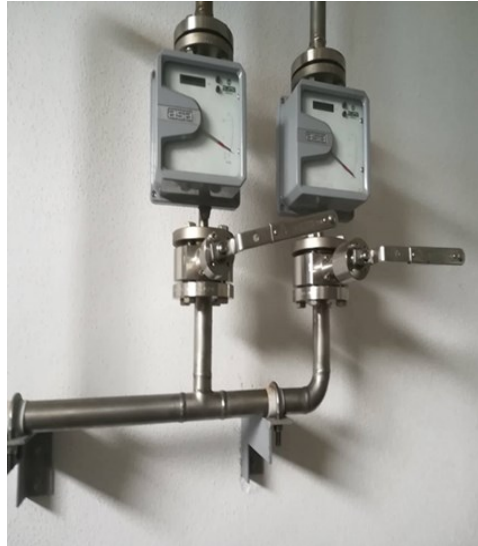
Slika 7. Rotametri za doziranje tekućeg kisika (Izvor: autor)
