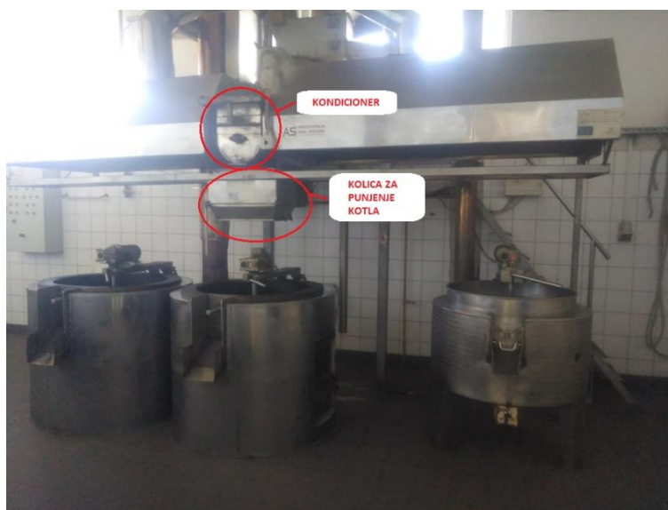
Slika 4. Kondicioner i kolica za punjenje kotla (Izvor: autor)
