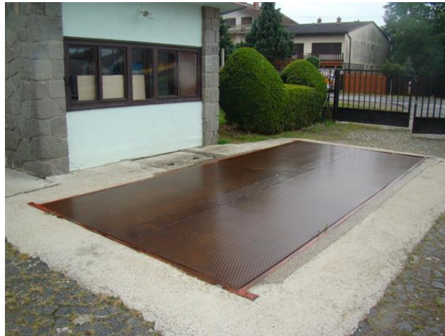
Slika 2. Mosna (kolna vaga) (vlastita fotografija)
