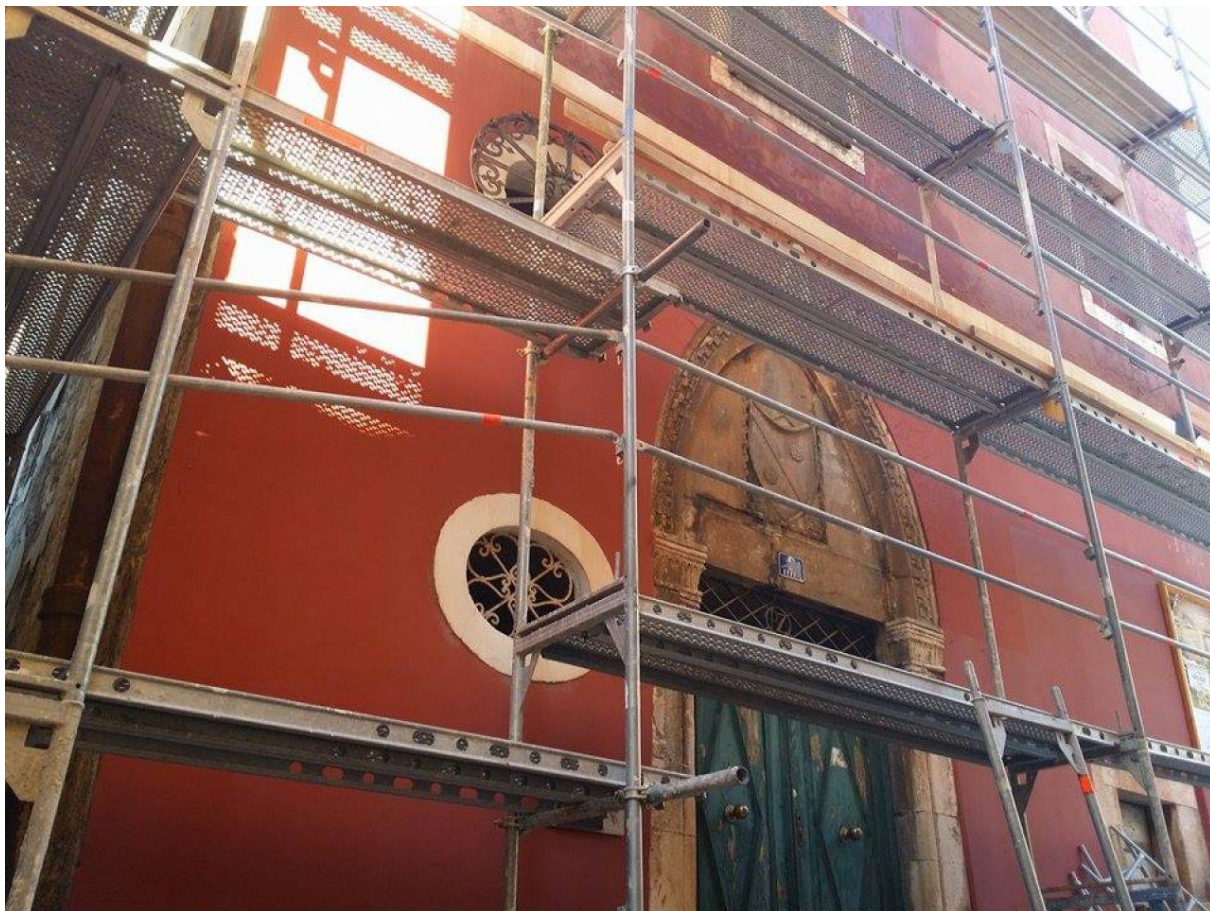
Slika 1. Uporaba tuđe nekretnine radi izvođenja radova
