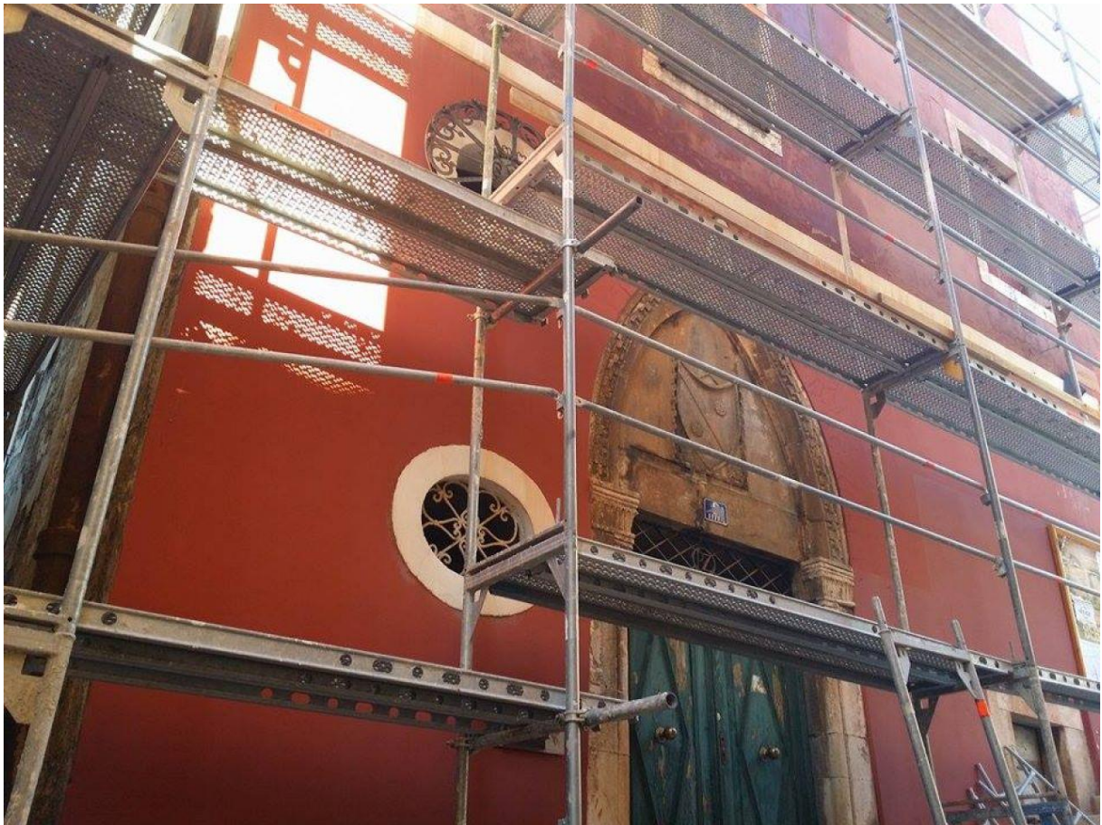
Slika 1. Uporaba tuđe nekretnine radi izvođenja radova
