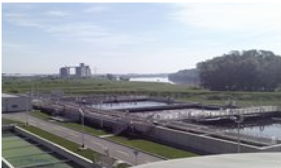
Slika 5. SBR bazeni (Vodovod Slavonski Brod, n. d., URL)
