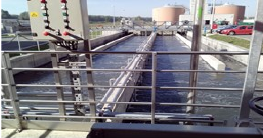
Slika 4. Pjeskolov–mastolov (Vodovod Slavonski Brod, n. d., URL)
